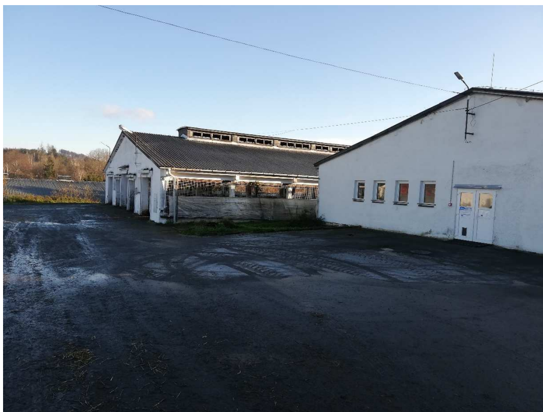
Stáj určená k rekonstrukci, v popředí dojírna
