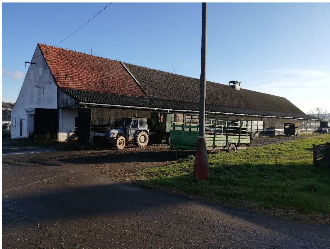
Pohled na stáj určenou k demolici
